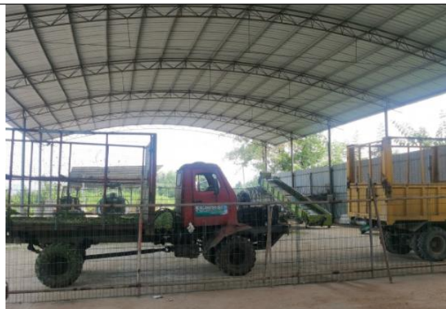
丰都县大地牧歌农业发展有限公司厂房堆料作业区
