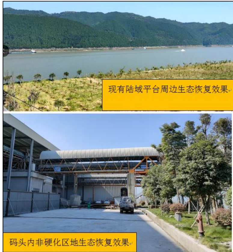
图 2.2.3-1 现有工程生态恢复情况
